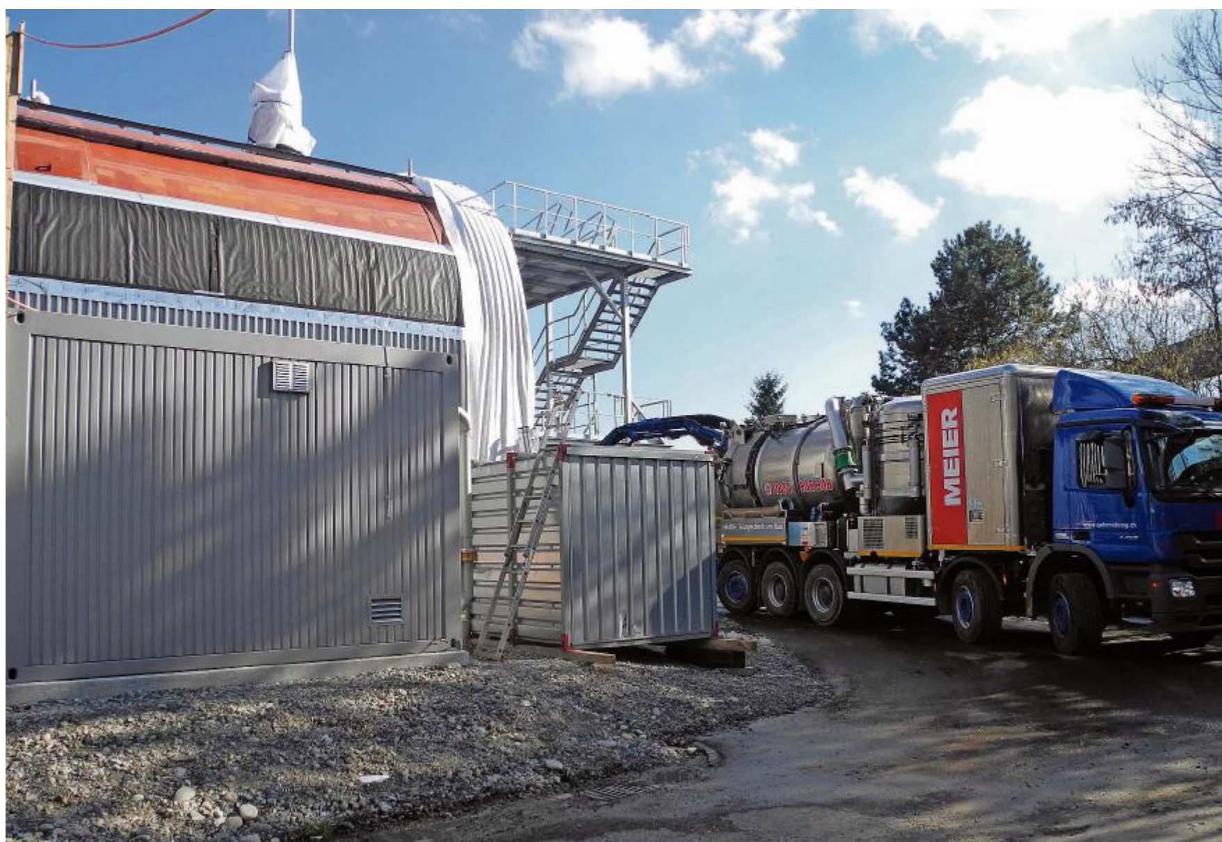
Der Fermenter im Vergärwerk Werdhölzli funktioniert nicht wie gewünscht. Er muss repariert werden.
