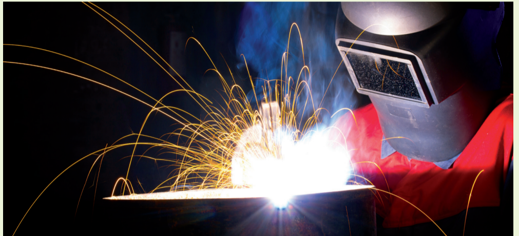
Beim Schweiessen können Nanopartikel freigesetzt werden. Bild: SECO
